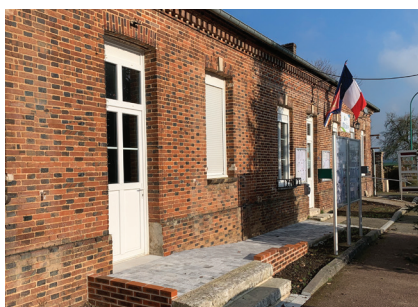
Entrée salle des mariages avec rampe d'accès handicapé
