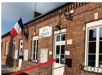
Nouvelle entrée avec rampe d'accès handicapé
